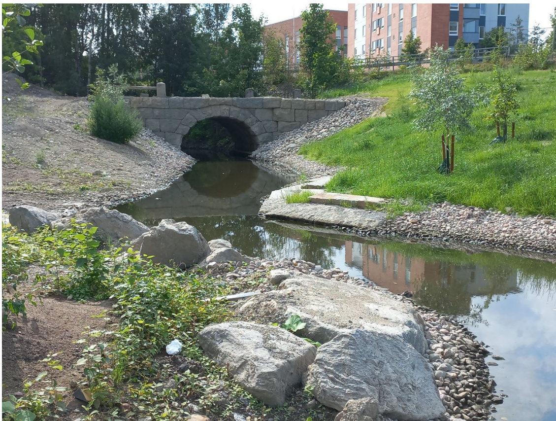
Kuva 4 Härmälänojan suulta purettiin putkitus vuonna 2022 (kuva: Tampereen kaupunki).
