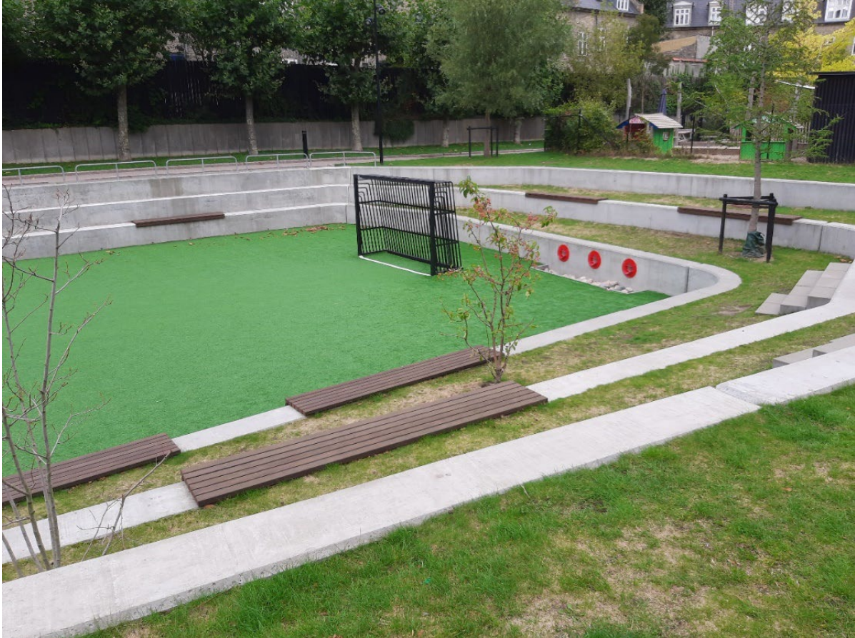
Kuva 7 Esimerkki hulevesien hallinnan monikäyttöratkaisusta Kööpenhaminan Carlsbergissa, jossa on yhdistetty hulevesiallas ja pelikenttä sekä katsomo ja viheralue.
