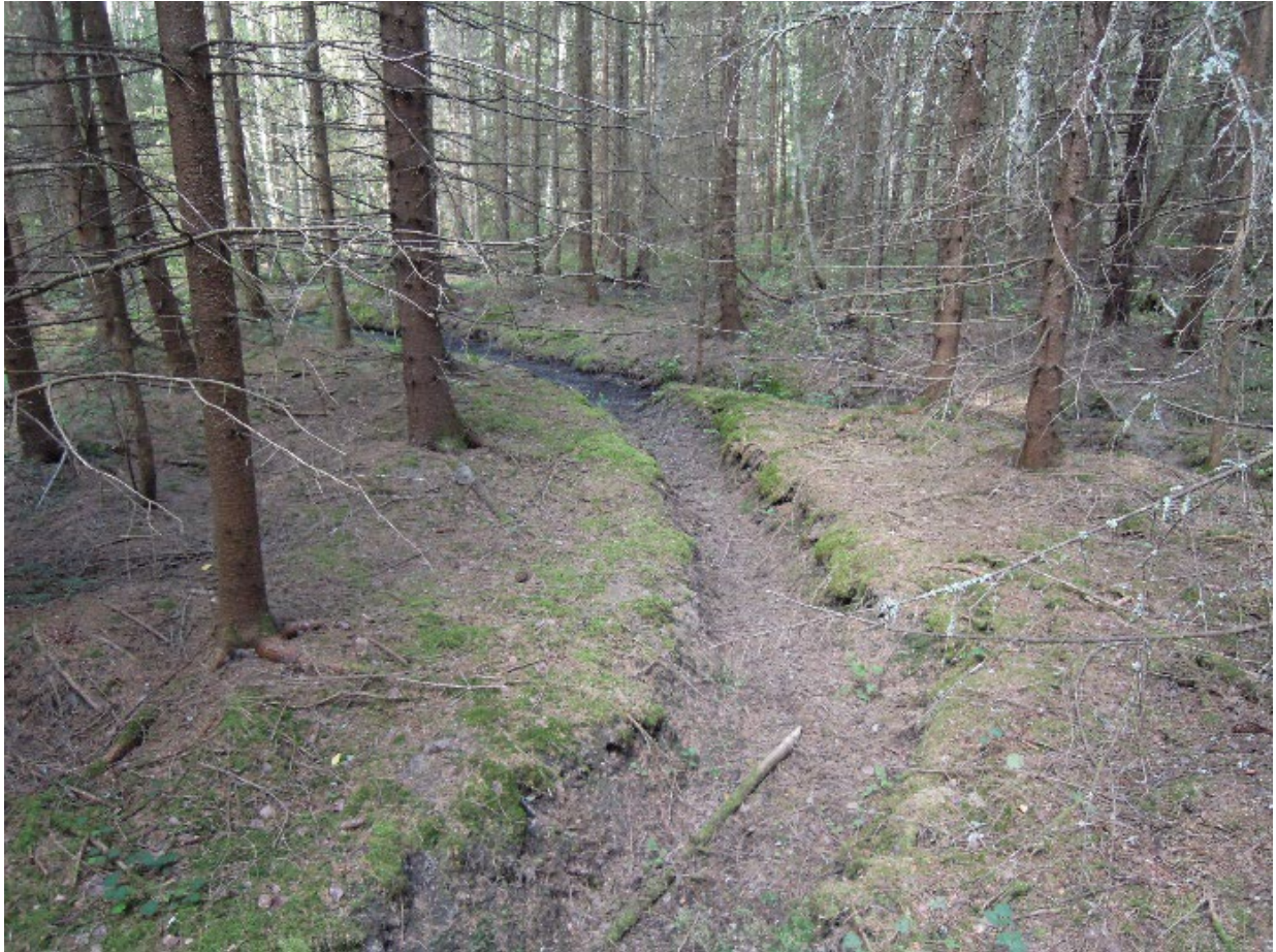
Kuva 6 Särkijärveen laskeva oja on voimakkaasti muokattu ja paikoin syöpynyt suuren virtausnopeuden takia kuljettaen kiintoainesta järveen isoilla virtaamilla. (kuva: AFRY Finland Oy)
